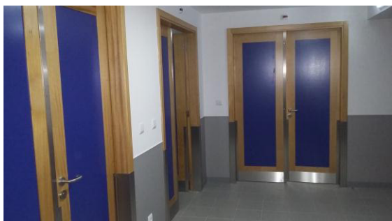
Figura 86 – Requalificação dos SFA - Entrada
