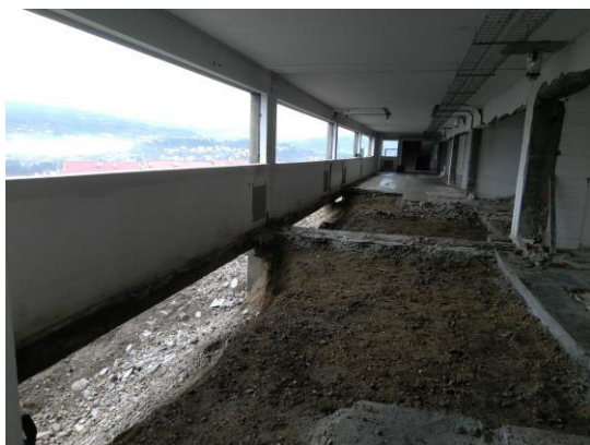
Figura 60 - Execução de nova laje no piso de RC
