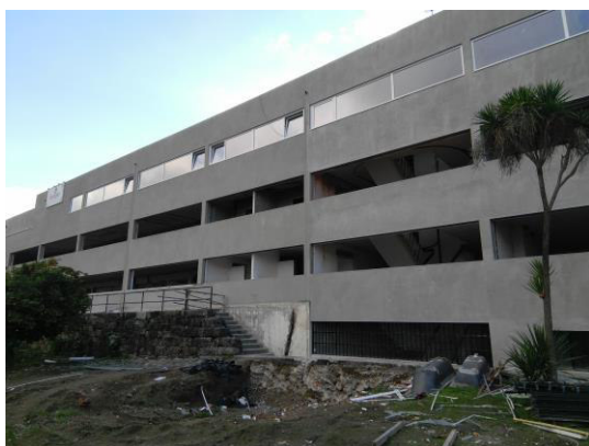
Figura 62 - Substituição das caixilharias
